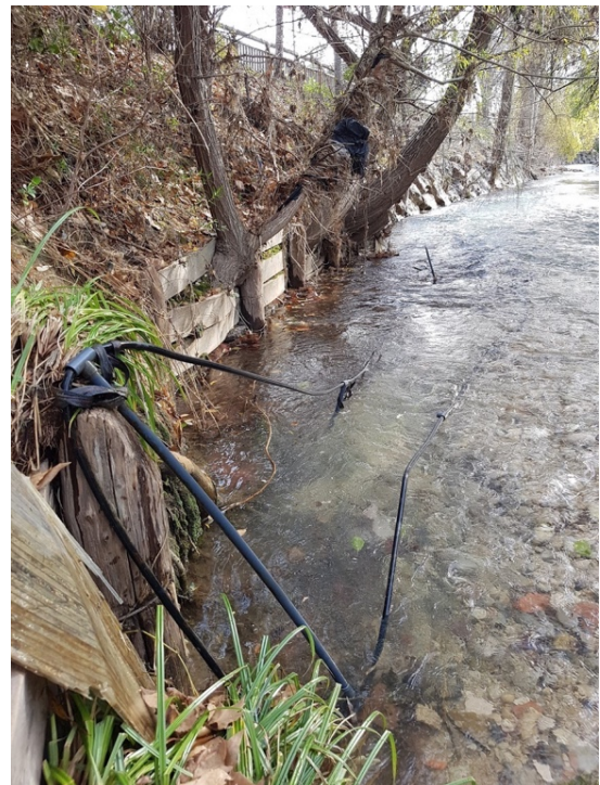
Figure 50 : Antenne endommagée lors de la crue cinquantennale (MRM)
