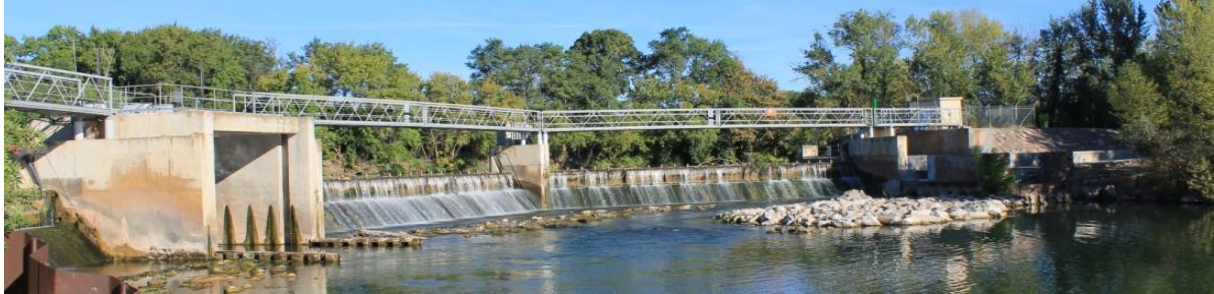
Figure 58 : Barrage et passe à poisson de Bladier-Ricard sur le fleuve Hérault
