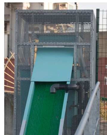
Figure 44 : Passage d'anguille dans la passe à poissons de Sauveterre (dessus) et passe-piège à anguille d'Avignon (dessous)
